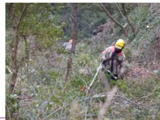
Débroussaillage manuel sur terrain pentu
