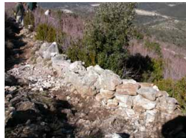
Canalisation de la fréquentation par des murets en pierres sèches (Chemin des Venturiers - Vauvenargues)
