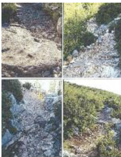
Traitement du lit de sentier : casse des têtes saillantes, bouchardage, décroisement latéral
