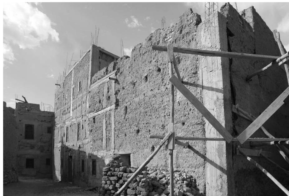
Exemple de tentative de renforcement structurel à éviter, car une structure non homogène résiste moins bien en cas de séisme.
