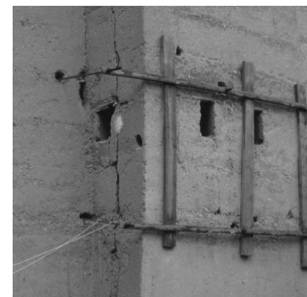
Structure en acier et bois chaînant provisoirement un mur fissuré
