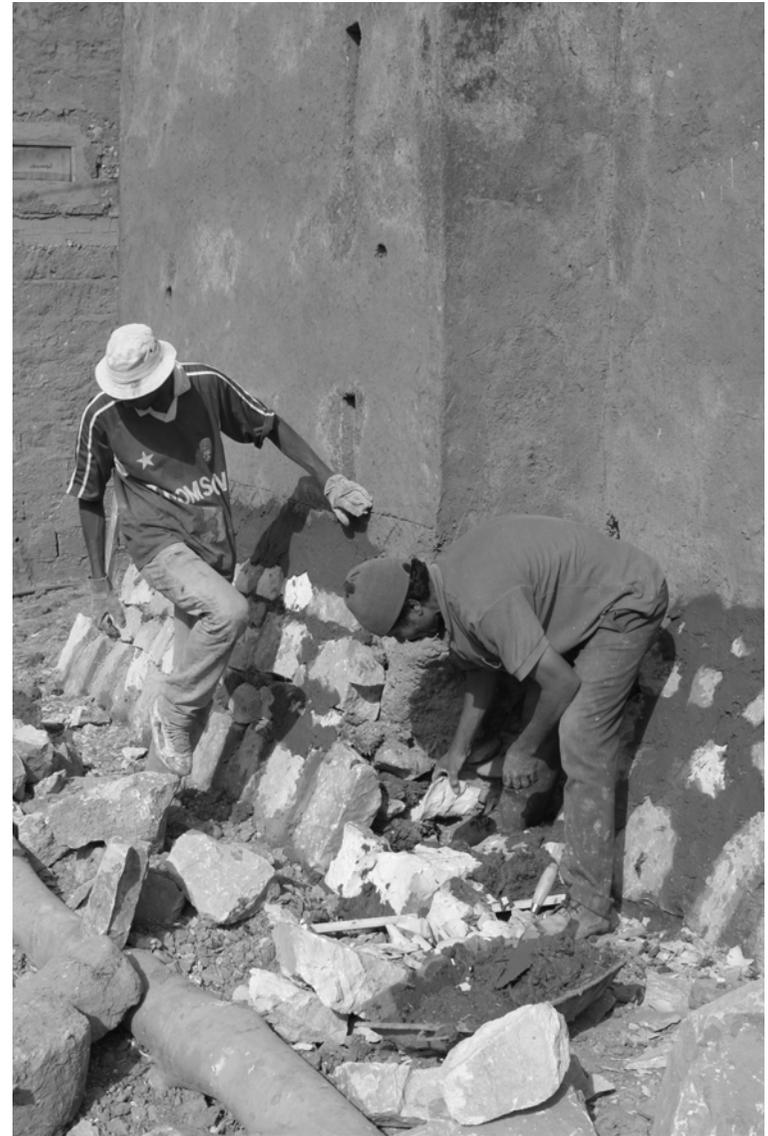
Renforcement de la base d'un mur élevé par un doublage en pierres
