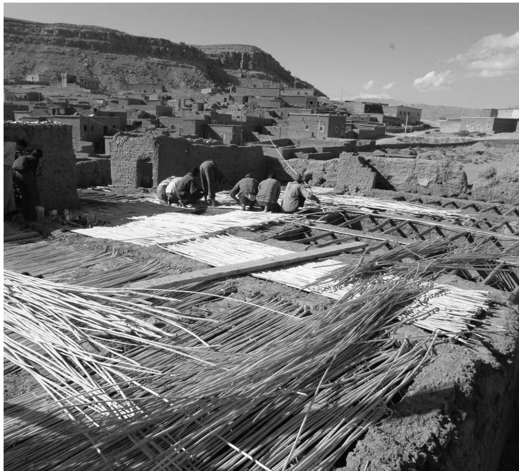
Reconstruction d'une toiture en terre sur plafond en roseaux
