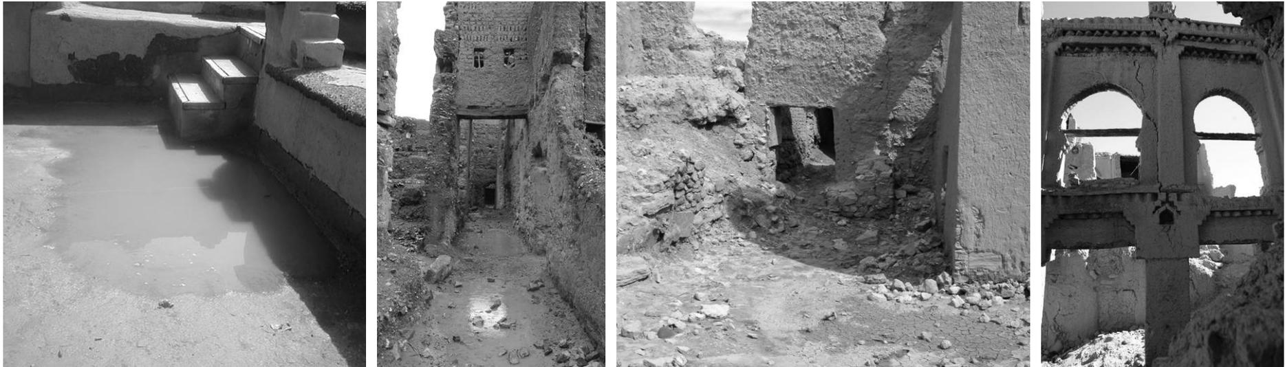
Le mauvais drainage des sites entraîne des stagnations d'eau qui humidifient les structures et finissent par les déformer (photo de droite)
