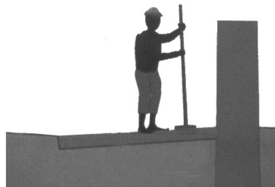
Façonnage des pentes d'écoulement en terre le long d'un mur d'enceinte.
