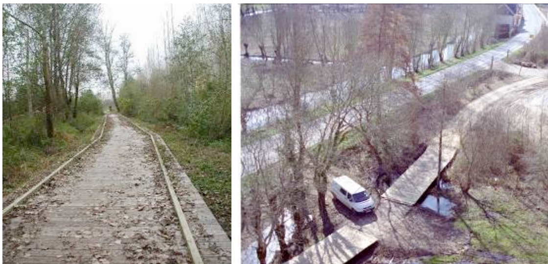
Exemple de section : Section Coulon-La Garette : platelage bois entre chemins blancs - Travaux sur secteur inondable, site classé et N2000
