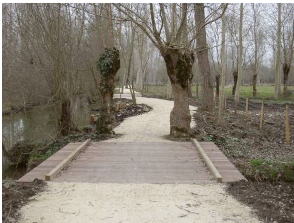
Exemple de section Bessines – passerelle plane en bois, chemin blanc entre frênes existants.
