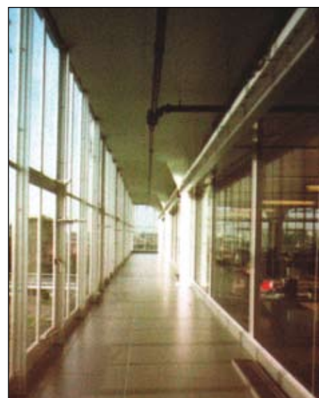
▲ Fig. 108a et 108b - La reconversion de l'usine Van Nelle à Rotterdam (arch. W. De Jonge) en centre de métiers du design. La façade vitrée de la façade, emblématique du taylorisme de l'industrie des années 20 et 30, est préservée dans son intégralité, grâce à l'insertion d'une deuxième peau intérieure, qui articule espace de circulation et espace d'activités.
