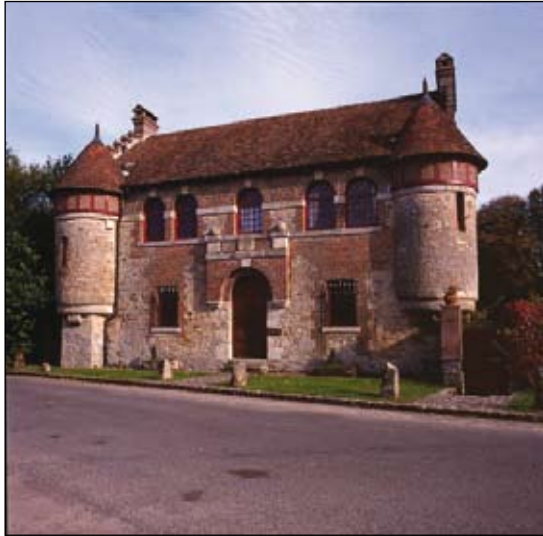
▲ Fig. 95 - Le moulin du Vidamé à La Chapelle-sous-Gerberoy, avec sa façade emblématique cantonnée de deux tourelles d'angle en encorbellement.
