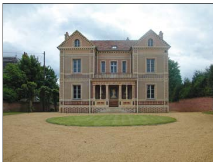
▲ Fig. 97 - La maison patronale Boulanger à Auneuil, construite en 1875. Elle est entièrement recouverte de carreaux céramiques, véritable catalogue de la production de l'entreprise.
