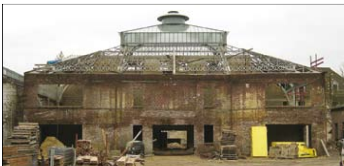
▲ Fig. 102 - L'usine Parvillée à Cramoisy (Oise) : un double défi : créer dans cet ancien four à porcelaine un habitat adapté au confort contemporain, et assurer une relation urbaine avec le centre ancien.
