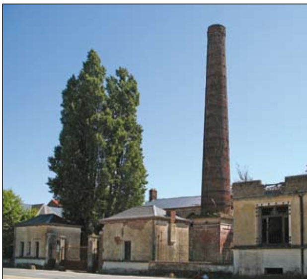
▲ Fig. 98 - Vue d'ensemble de la sucrerie de Francières, inscrite à l'Inventaire supplémentaire des Monuments historiques en 1999. Elle fait aujourd'hui partie des trois sites régionaux retenues pour accueillir un futur centre d'interprétation consacré à l'industrie et aux bio-technologies.
