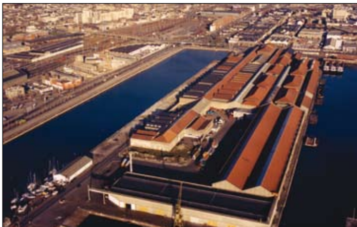
▲ Fig. 103 - Les docks Vauban au Havre (Seine-Maritime) : ancien entrepôts de coton et de café
