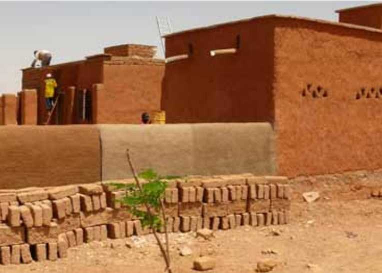
Figure 7 : Logement du gardien de la MCB en chantier, 2008. © L. Cissé
