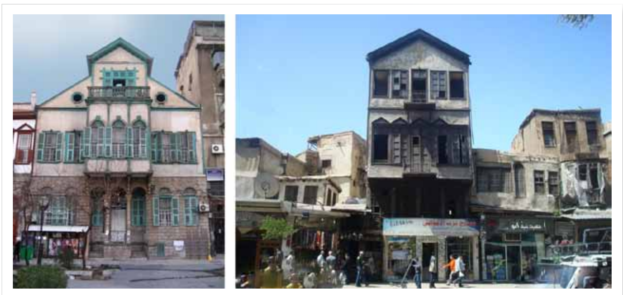
Photo 1 : Gauche : maison bourgeoise, en pierre, en terre et en bois, du style de konaks, quartier de 'Arnous, sur la route de Sālihiyyeh, dernière décennie du XIX e siècle. Droite : Tranche de constructions du faubourg de Qanawāt, en terre et en bois, fin du XVIII e siècle. © A. Soufan
