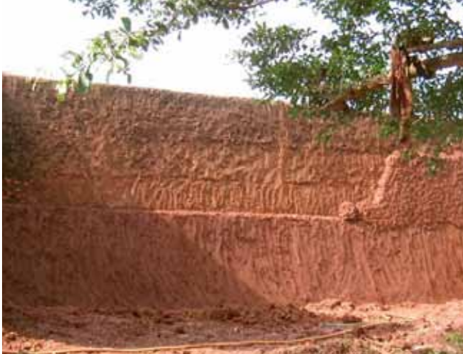
Photos 2 à 6 : Typologie constructive des palais et réfection d'une toiture en chaume. © L. Ahonon
