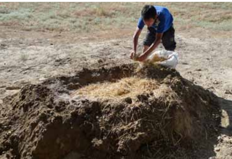
Figure 5 : Préparation du mélange de terre, balle de riz et paille. © CRAterre-ENSAG
