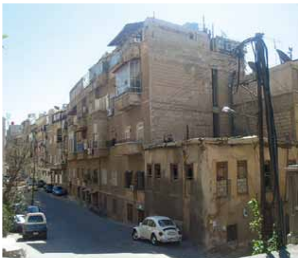
Photo 4 : Les deux générations de constructions du quartier al-Muhājirine. Au premier plan une construction en bois et en briques de terre crue ; derrière une barre de nouvelle génération de bâtiments : immeubles en béton armé. © A.Soufan
