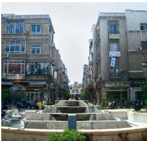
Photo 5 : Les immeubles et la place principale du nouveau quartier Haraqah, construit en majorité en béton armé, sur le site d'ancien quartier Sidi Aoud. Au fond d'illustration apparaît le tissu ancien de Vieux Damas. © A.Soufan
