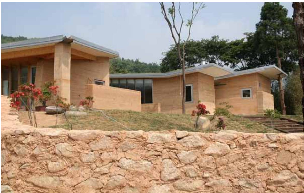
Image 10 : Maison d’un ancien chef de l’État de la République de Corée, projet de l’architecte Chung Gu-Yon et Guyon architects, bâtie en pisé par l’architecte entrepreneur Shin Geun Shik. © Shin Guen Shik
