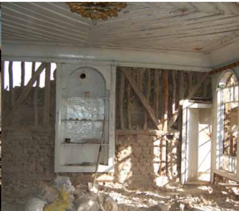
Figure 3 : Réhabilitation d'une maison ancienne, avec reconstitution d'un mur donnant sur l'extérieur et intégration d'une niche. © Samir Abdulac
