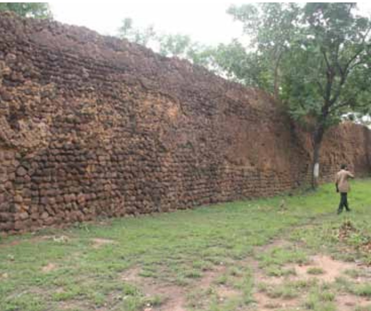
Figure 7 : Façade sud des ruines. © L. Sîmporé
