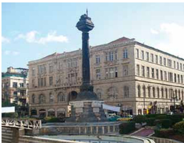
Photo 2 : Le bâtiment al-'Ābed, donnant sur la place de Marjeh, du style néoclassique, construit durant la première décennie du XX e siècle. © A.Soufan
