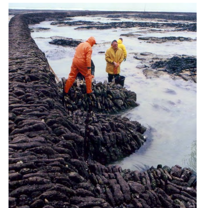
↑ Déversoir à marée en pierre à l'île de Ré, France.
