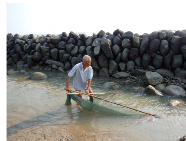
↑ Déversoir à marée en pierre dans la province de Fujian, en Chine.
